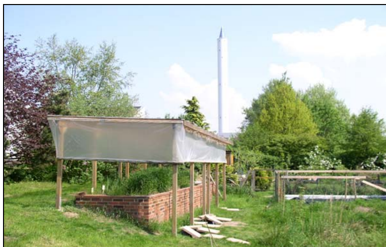
Abbildung 3: Ansicht der überdachten Lysimeterstation im Versuchsbetrieb (Mai 2006); im Hintergrund rechts das umzäunte Abwasserbecken
